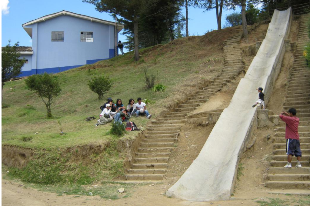
Foto 4. Resbaladero de piedra, constituye un riesgo de seguridad para los niños
